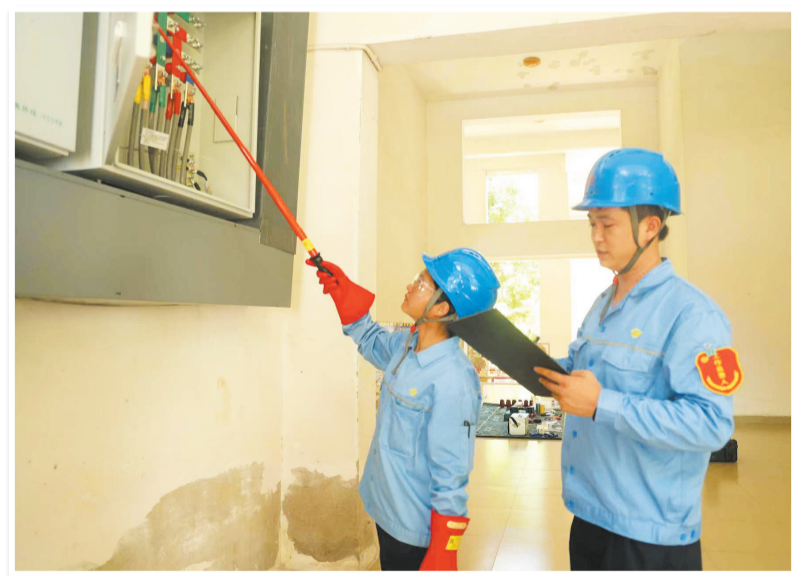
海南电网海口供电局组织施工人员对非直供小区进行电力抄表到户改造。 本报记者 周慧 通讯员 杨永光 摄
