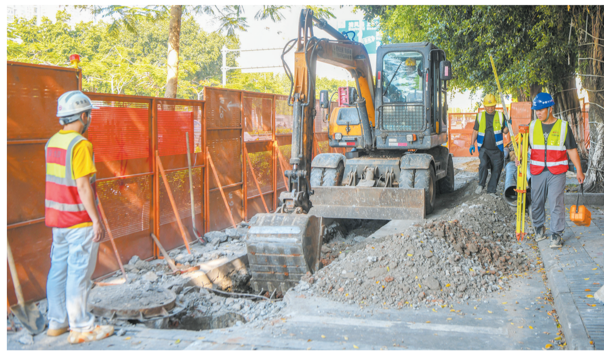
6月3日,在龙华区滨涯路,海口市电力沟清污分流工程现场,挖掘机正在破除路面。本报记者 苏强坤 摄
