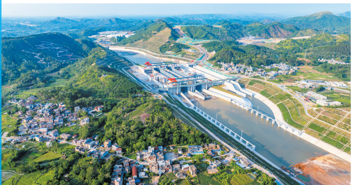
这是6月3日拍摄的广西平陆运河马道枢纽充水现场（无人机照片）。 新华社发
