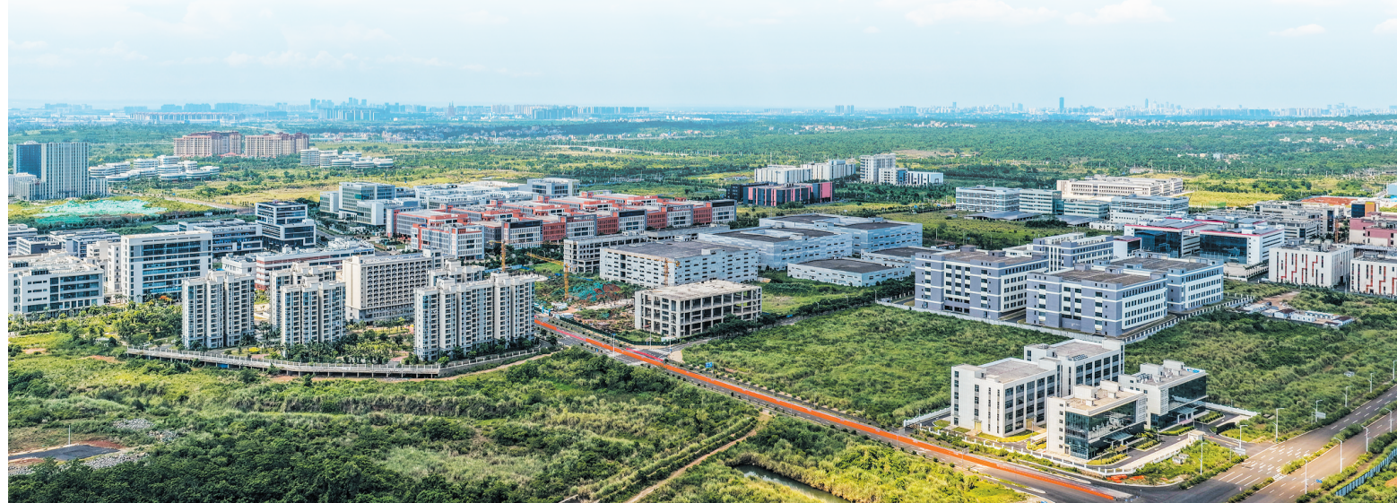
空中俯瞰海口美安生态科技新城,现代化厂房错落有致,勾勒出产业新城的蓬勃图景。
