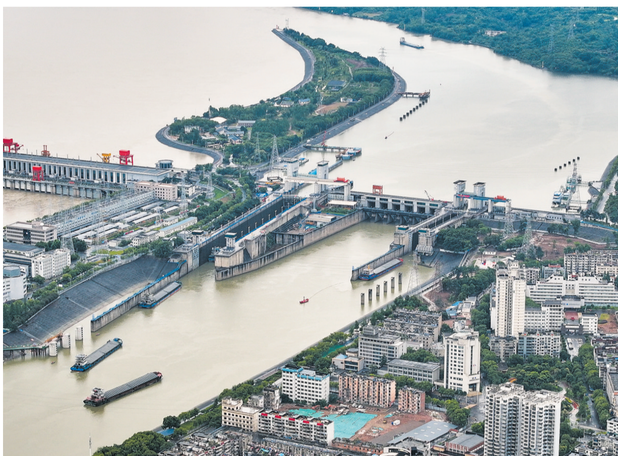
6月8日拍摄的三峡水运新通道工程葛洲坝航运扩能施工现场。 新华社记者 肖艺九 摄
