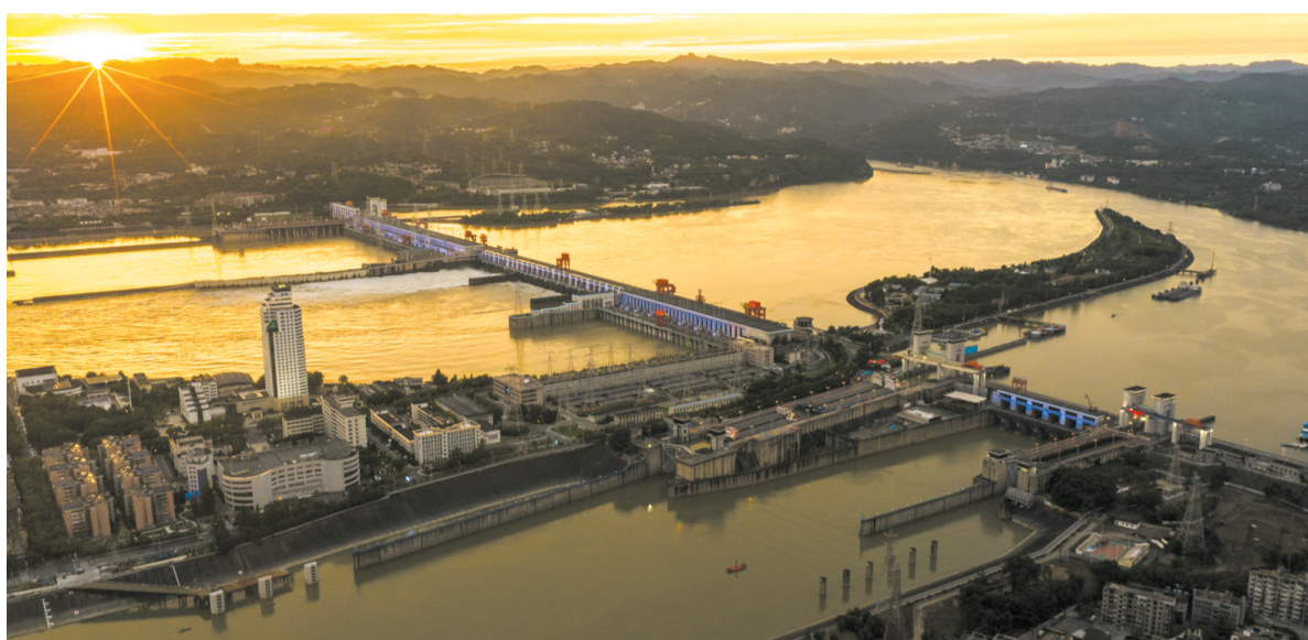
6月8日，夕阳映照在三峡水运新通道工程葛洲坝航运扩能施工现场。 新华社记者 肖艺九 摄
