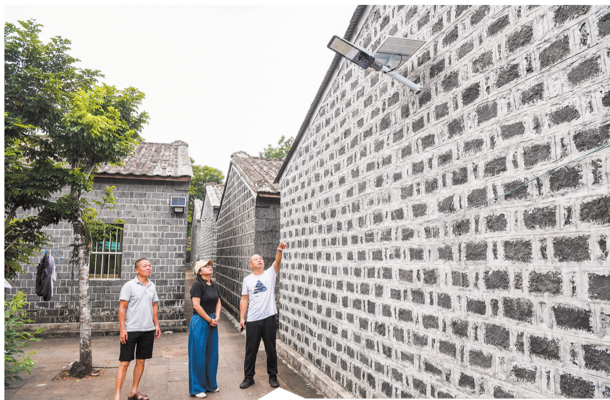
6月11日,龙华区龙泉镇永昌村233盏路灯完成安装调试,全村主干道、巷道及关键路口实现亮化。 本报记者 康登淋 摄
