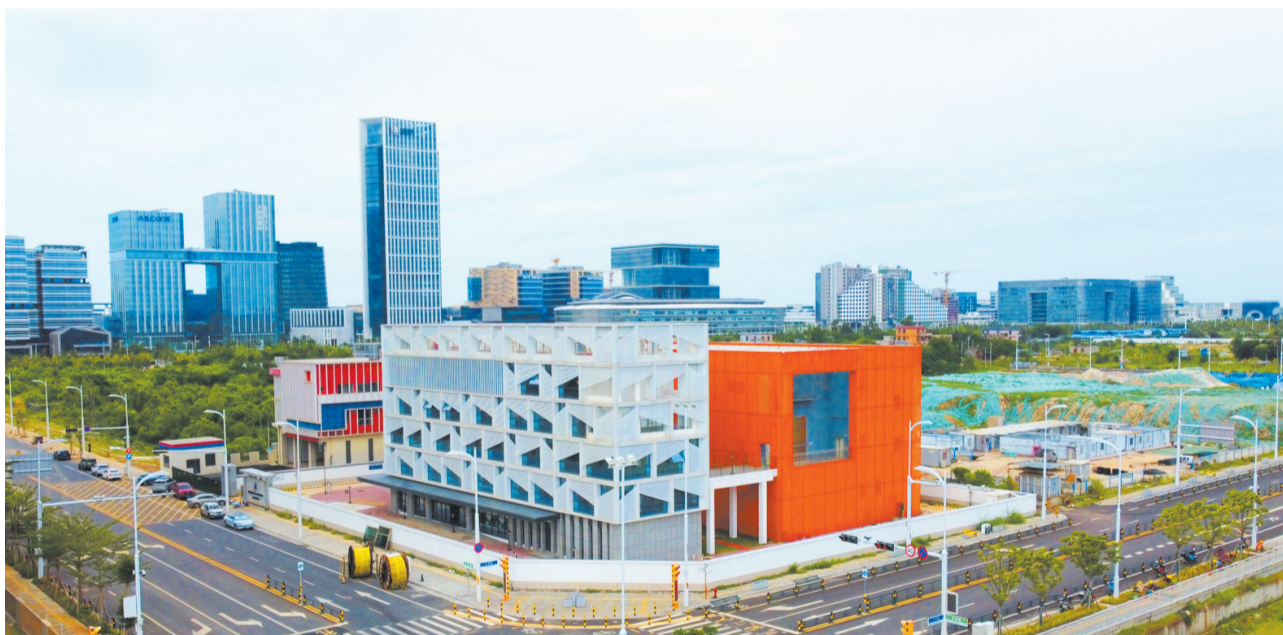
近日,海口桂林洋110kV福创输变电新建工程投入运营。本报记者 杨忠凯 摄
