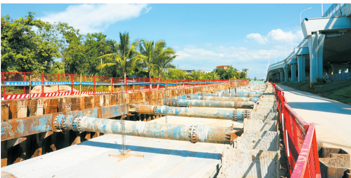
海口江东新区海文南路市政化改造项目地下综合管廊结构已实现全线贯通。本报记者 杨志凯 摄
