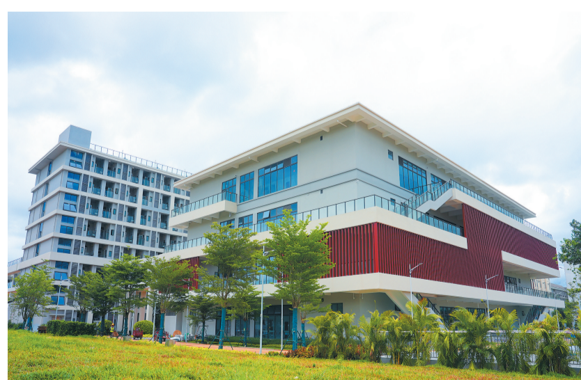
近日,琼台师范学院桂林洋校区学生食堂综合楼建设项目通过竣工验收。本报记者 杨忠凯 摄
