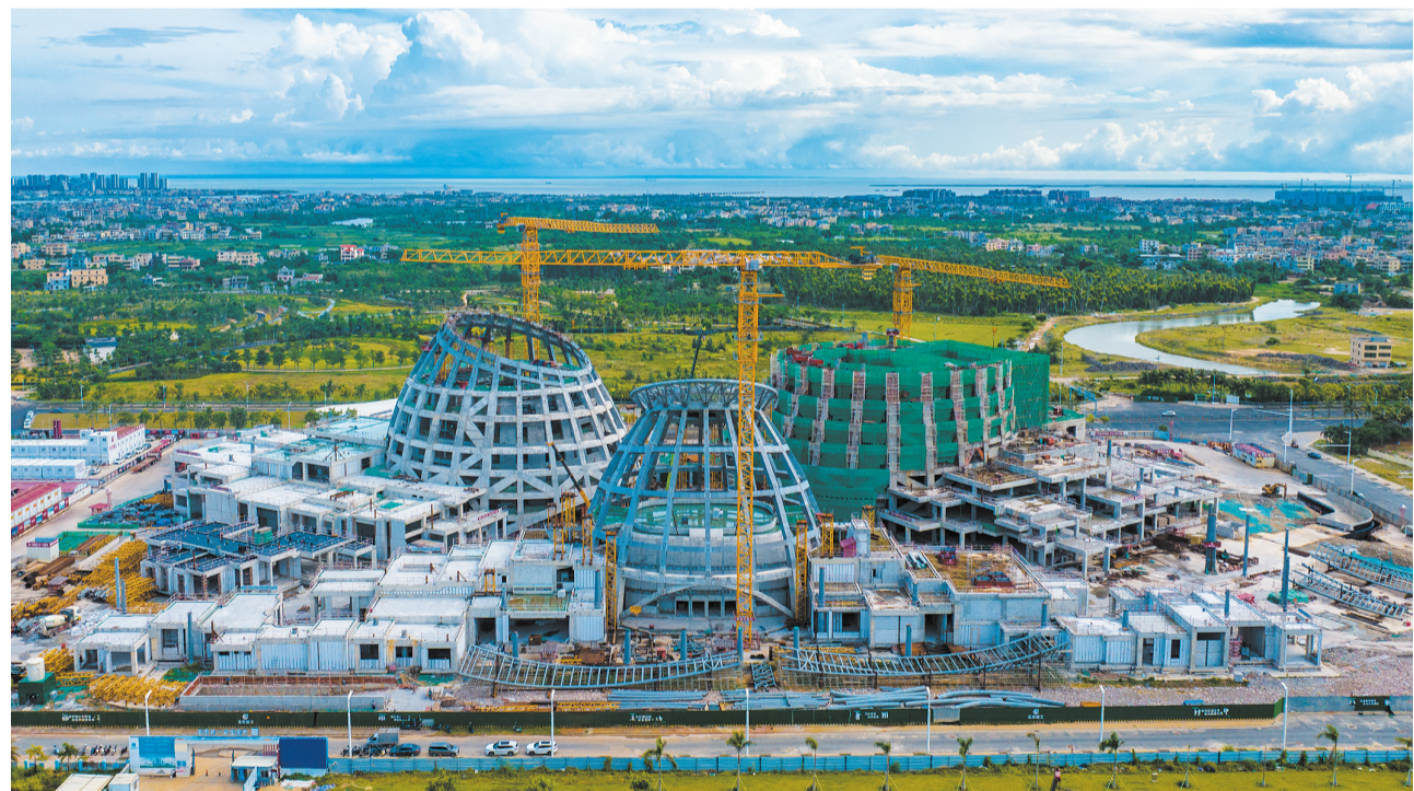
7月1日,俯瞰海南省艺术中心(演艺中心)项目现场,一派热火朝天的施工景象。 本报记者 杨忠凯 摄
