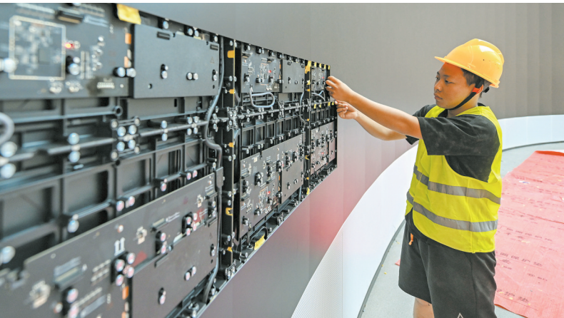
7月15日,在海南省综合交通运输运行协调和应急指挥中心(TOCC)施工现场,工作人员正在安装大屏幕。 本报记者 苏弼坤 摄
