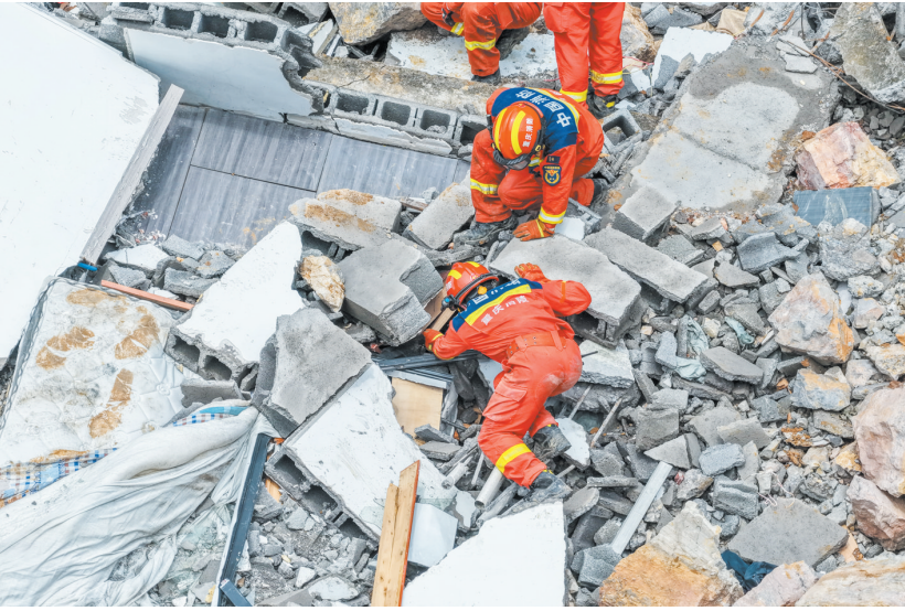
7月18日，救援人员在现场救援(无人机照片)。
