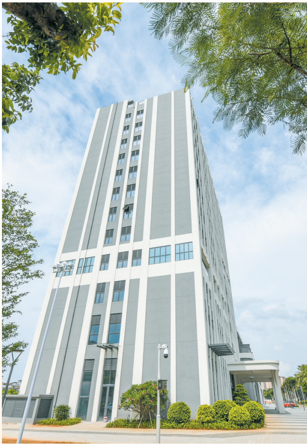
位于海口江东新区的海涛大酒店(一期)项目已顺利完工,正在进行收尾作业。 本报记者 康登淋 摄
