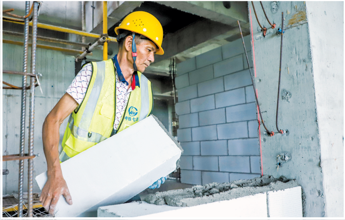
7月22日，在海南师范大学桂林洋校区留学生公寓及外籍教师公寓项目现场，工人正有序进行砌体及二次结构施工。
