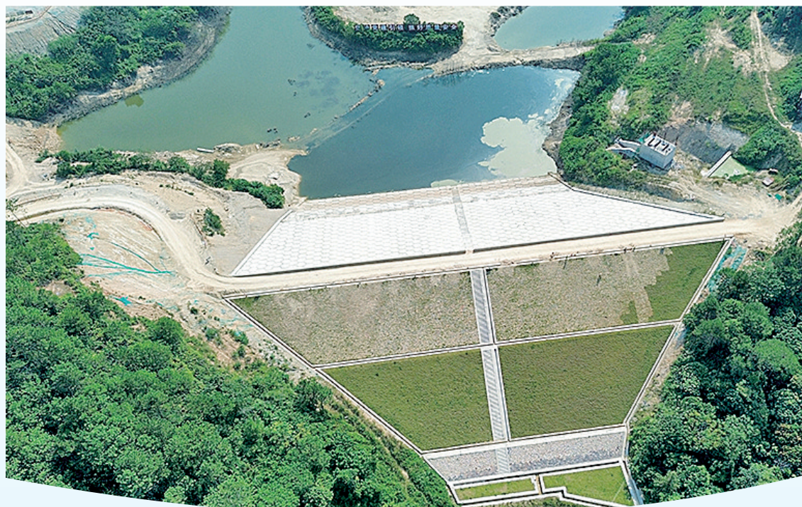
龙云灌区中甘岭水库已完成主体施工。(资料图)
