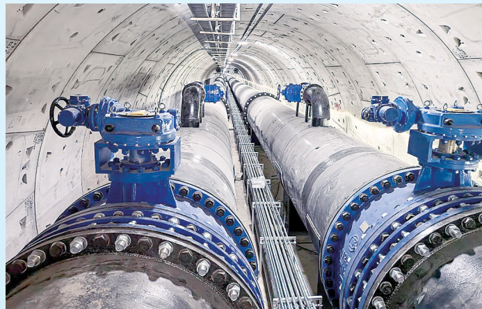
国内最长深海市政管网隧道全线正式通水。(资料图)
