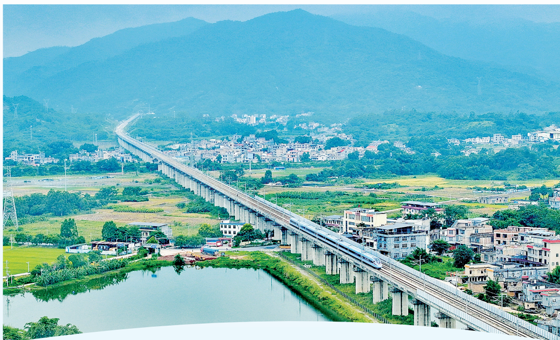
高铁穿越隧道,驶入玉林盆地。
