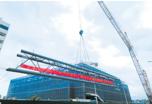
施工现场,巨型吊机平稳起吊钢桁架。
