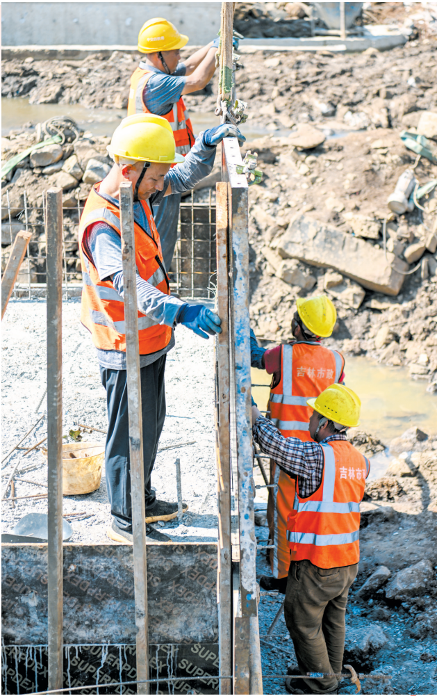
7月22日,在琼山区云龙镇本礼湖村桥施工现场,施工人员正在安装模板。
