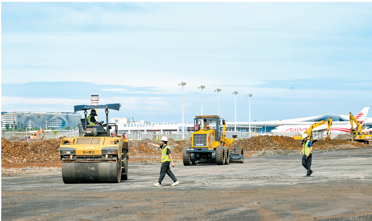
8月2日，海口美兰国际机场货运机坪扩建工程项目现场，施工人员使用大型工程设备进行道基碾压整形。
