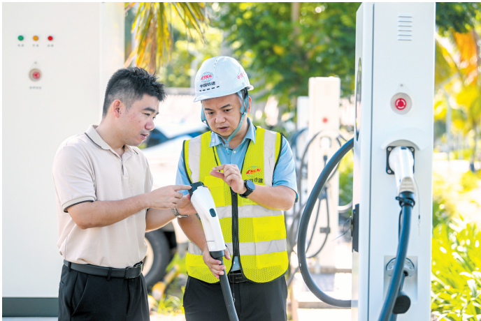
▲8月4日,在红城湖公园北侧充电站,施工单位正在检查刚完工的充电桩。 本报记者 苏弼坤 摄
