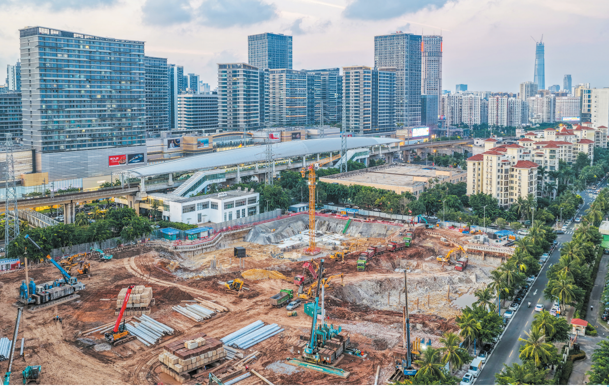
龙华区城西片区D-1-07地块项目正在加紧建设中。
