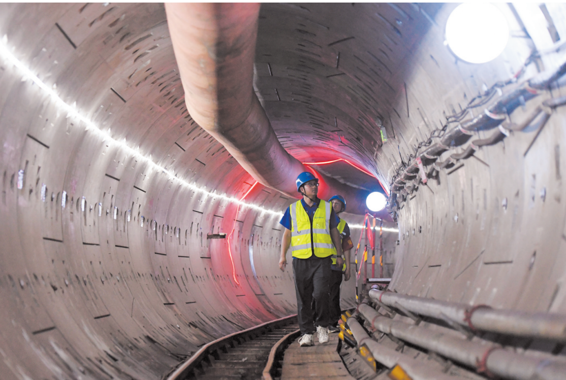
2024年7月30日，天津市滨海新区雨污分流改造工程项目雨水主管隧道内检查盾构管片。新华社记者 赵子硕 摄
