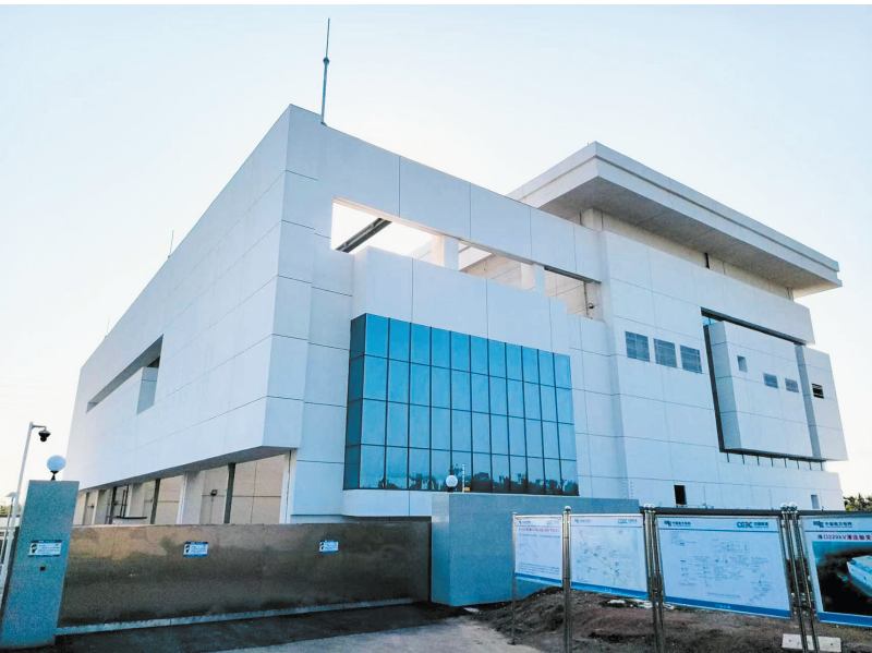
今年7月,海口220千伏潭连变电站正式投产送电,持续优化电网网架结构。 本报记者 周慧 通讯员 袁州 摄
