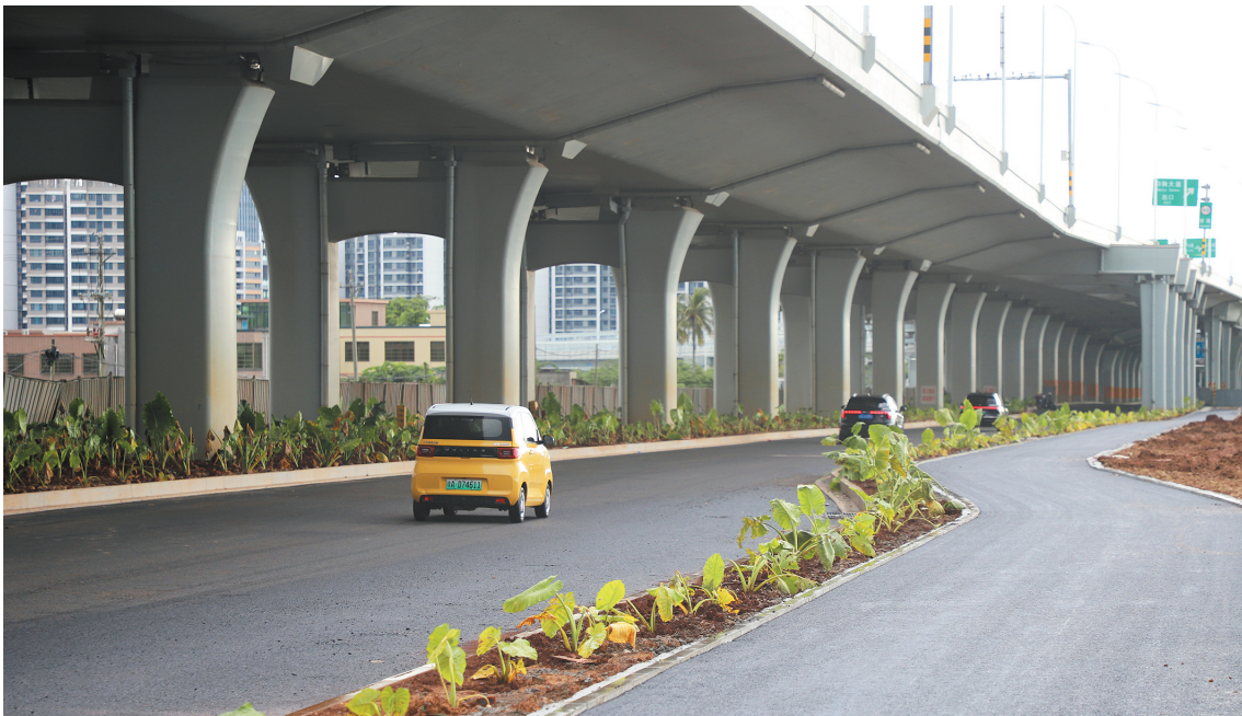
▲海口江东新区海文南路市政化改造项目椰海大道—白驹大道段近日通车,为区域群众出行、商贸物流往来再添便捷通道。 本报记者 杨忠凯 摄
