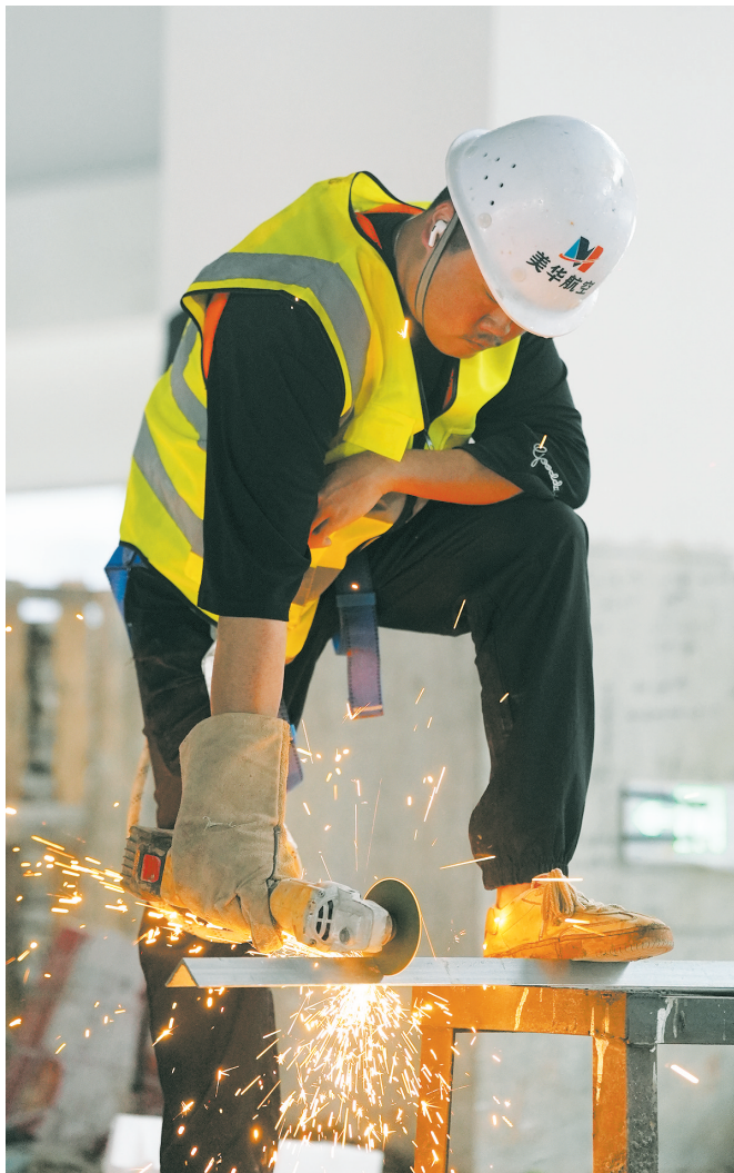
在美华航空(海南)智慧产业园,工人正进行室内收尾工作。
