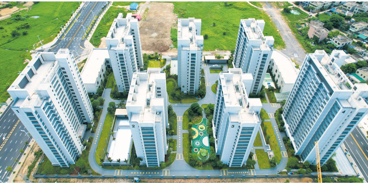
8月18日,俯瞰位于海口江东新区的春晖园A06地块安置房项目。 本报记者 杨忠凯 摄
