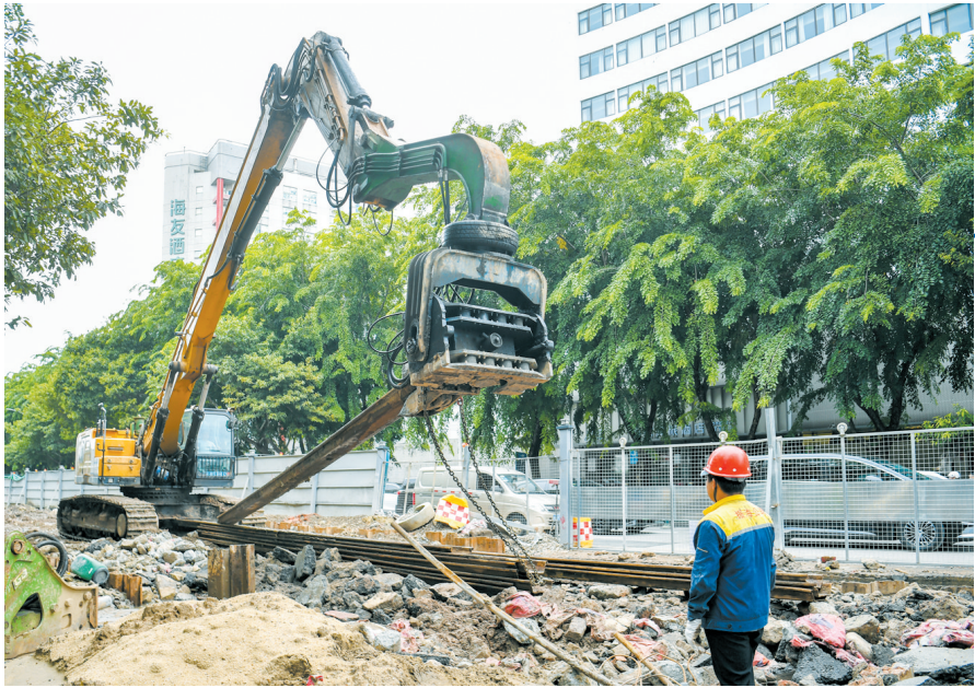
8月18日,在海秀东路排水改造工程现场,施工人员操作机械打钢板桩。
