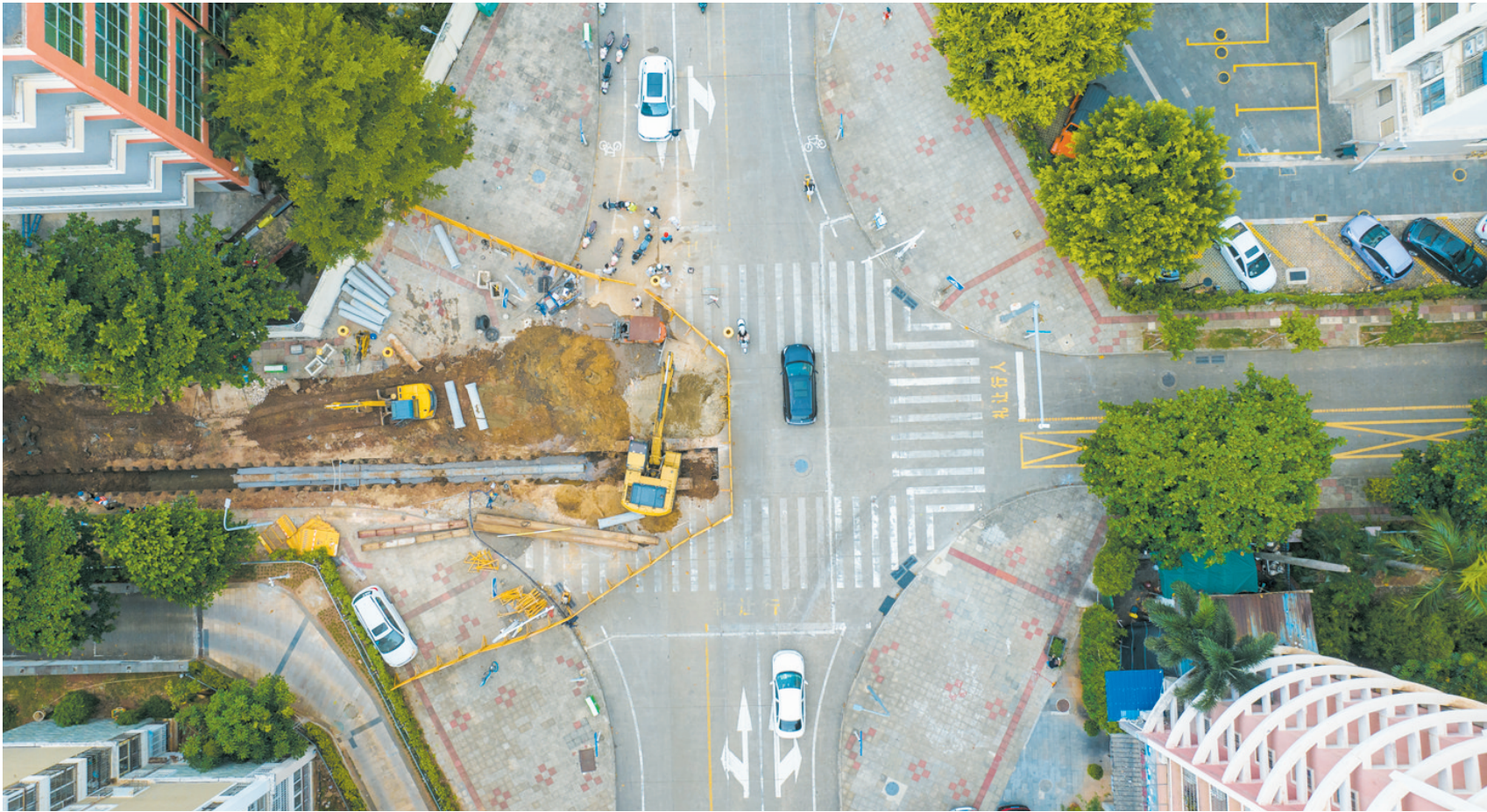
8月20日拍摄的傍海路施工点位。
