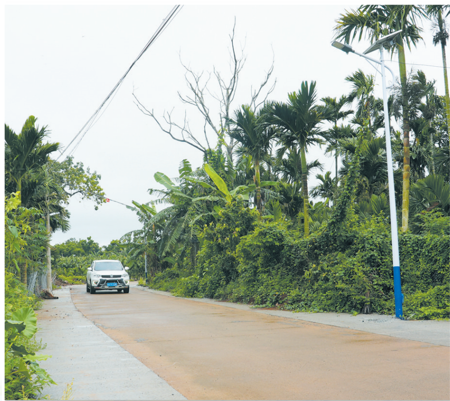
▲秀英区石山镇安仁村委会桐梧村改造后的通村主干道平整宽阔,道路两侧绿植规整,私家车、农用车能够顺畅交会。 本报记者 杨忠凯 摄
