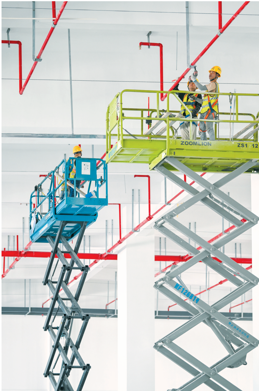
海口新海陆岛物流园区起步区工程项目(A包)施工现场,工作人员在进行消防管道施工。 本报记者 苏弼坤 摄
