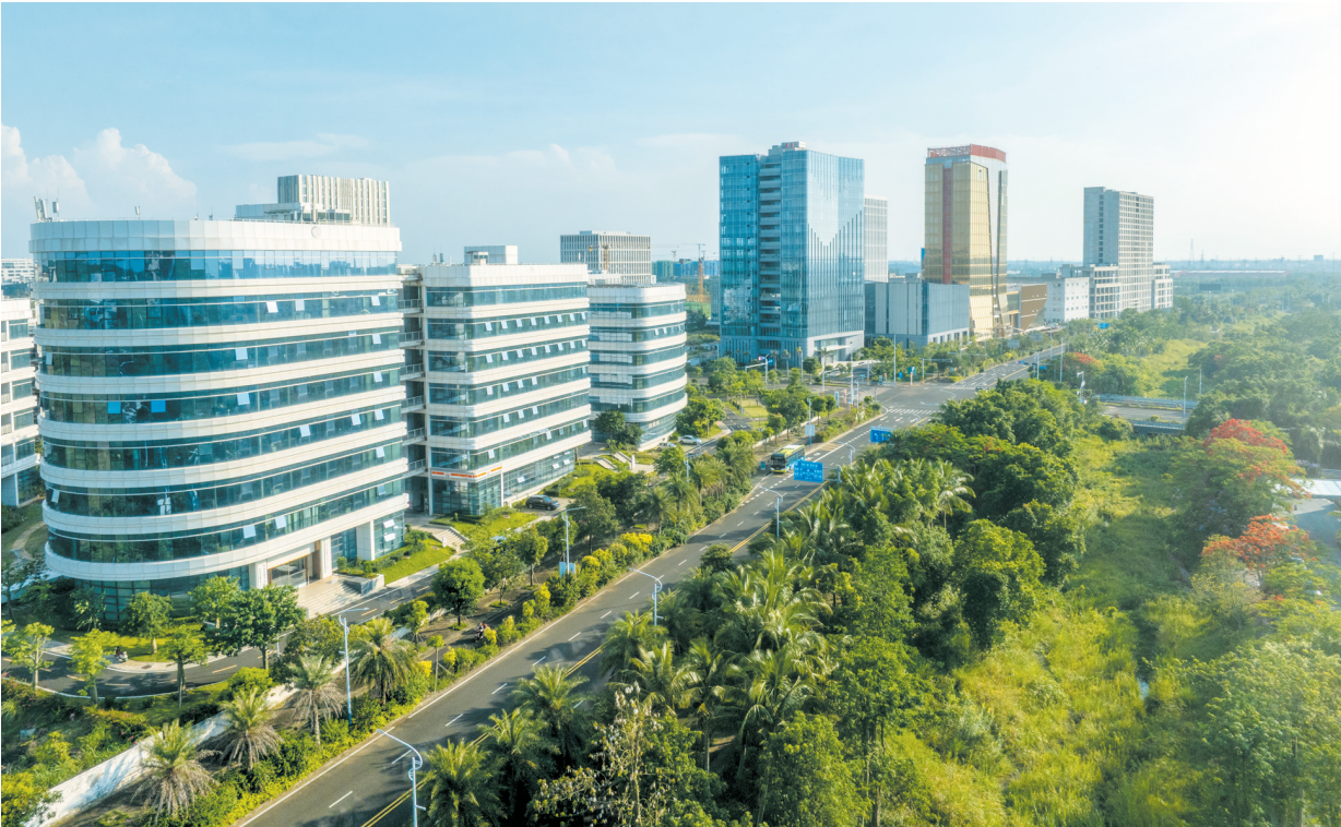
海口国家高新区美安生态科技新城高楼林立,重点项目相继落地,产业发展迅速。 本报记者 石中华 摄
