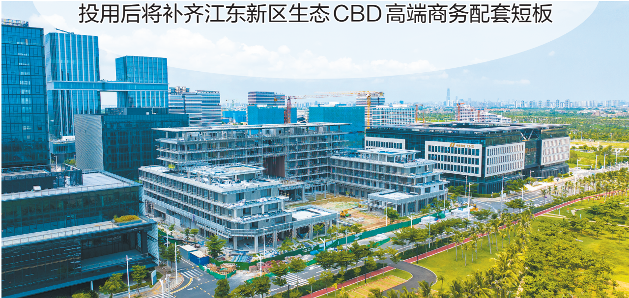
俯瞰位于江东新区总部经济区(生态CBD)的海南京东供应链总部项目,各项建设任务稳步推进。 本报记者 杨忠凯 摄
