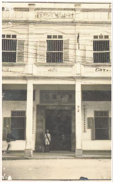
▲位于海口骑楼老街的益泰兴侨批局旧址。 海口市龙华区侨联供图
