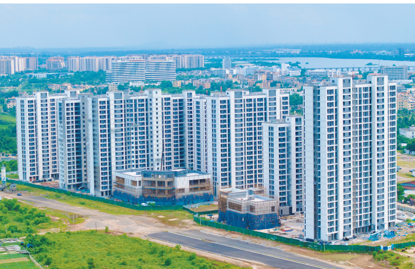
8月28日,正在建设中的重点民生安居工程兰香园D04、D06地块项目。 本报记者 杨忠凯 摄
