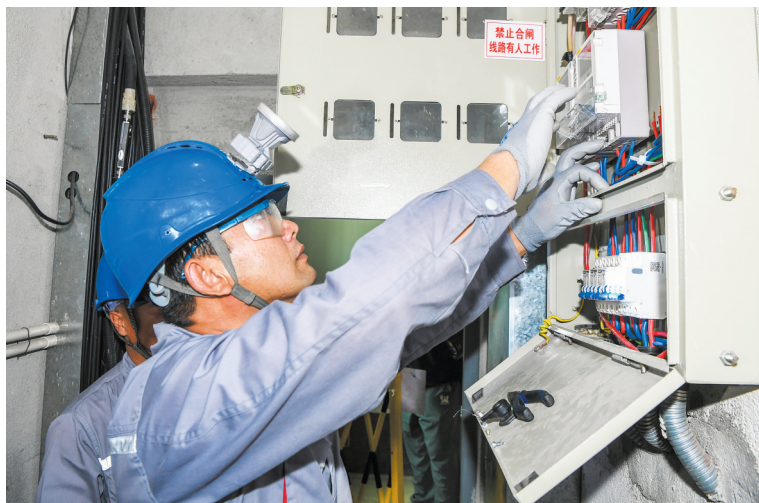
在红城湖国际广场小区,海南电网公司海口供电局工作人员正在安装抄表到户设备。
