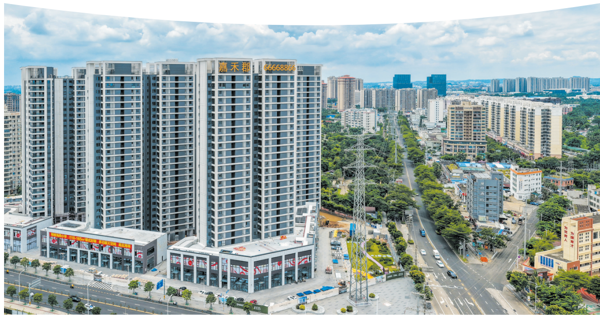
9月5日,海虹化纤片区城市更新项目一期(嘉禾郡)楼宇外立面已亮相,预计今年12月竣工验收。
