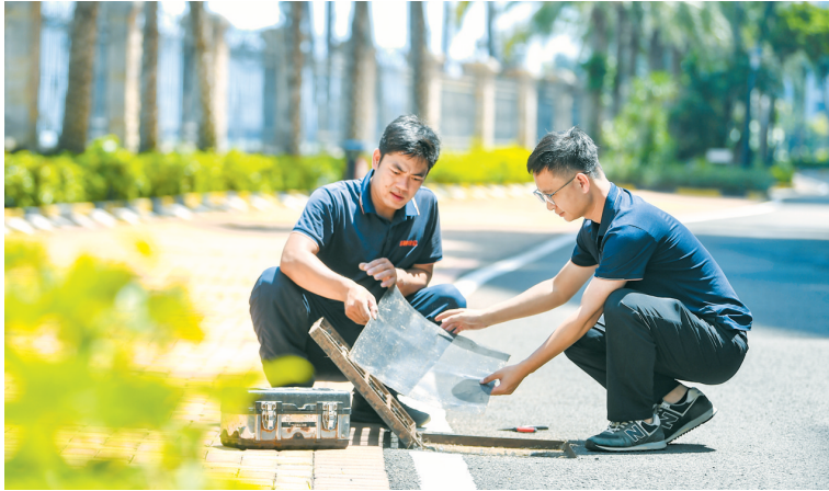
在恒大美丽沙天泽湾小区内,物业工作人员检查排水井盖下的防蚊网。
