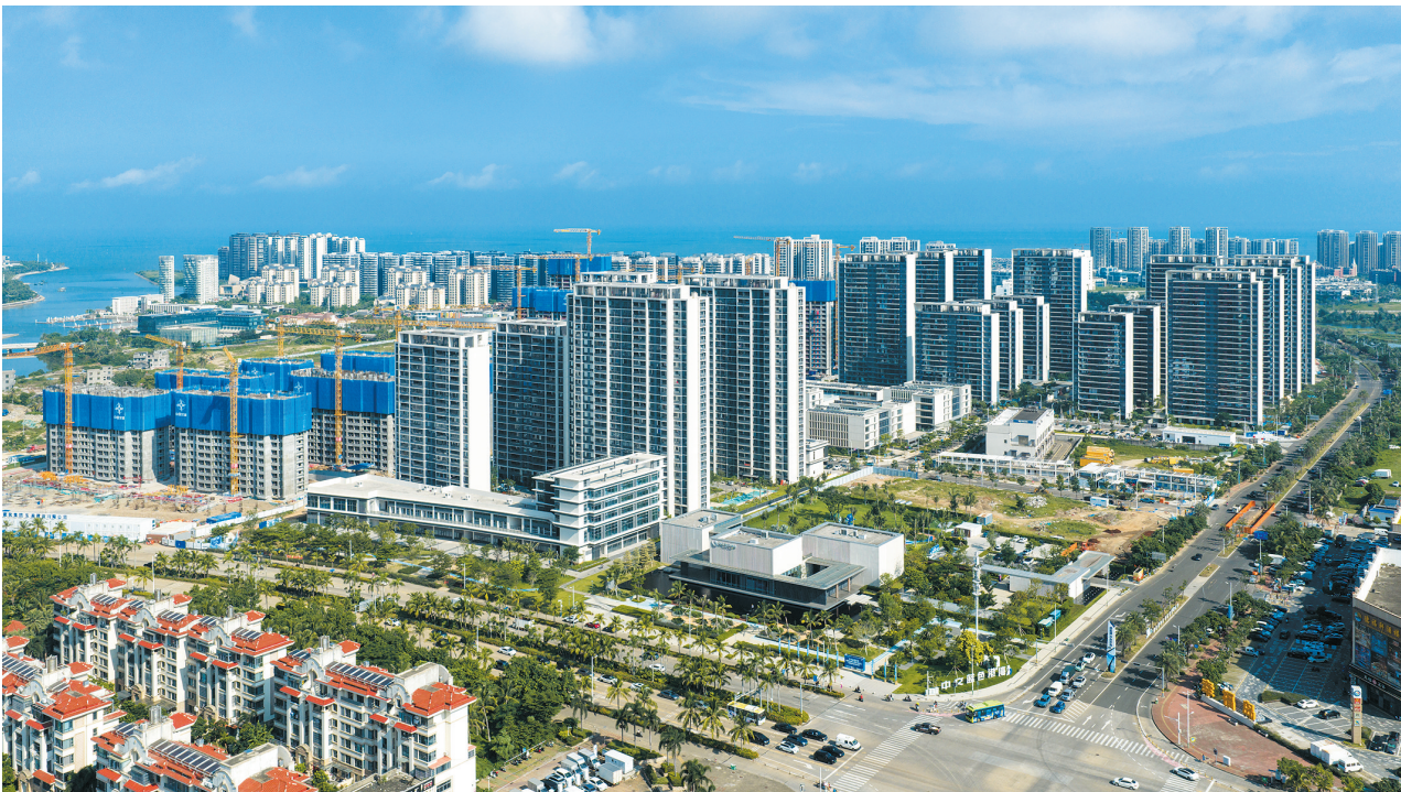
加快建设中的海口市横沟村城市更新项目,目前二期示范区主体完工已经过半。 本报记者 高潮 摄
