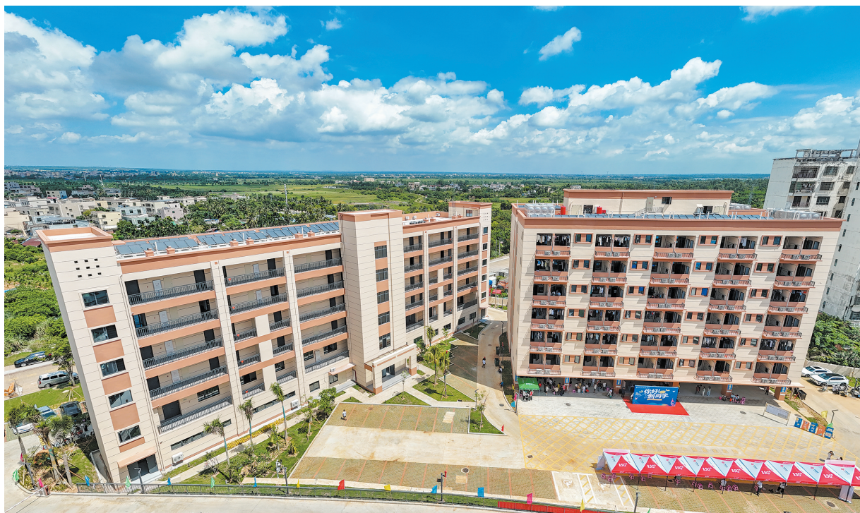
9月6日，海南省交通高级技工学校全新后勤服务楼正式竣工投用。本报记者 苏弼坤 摄
