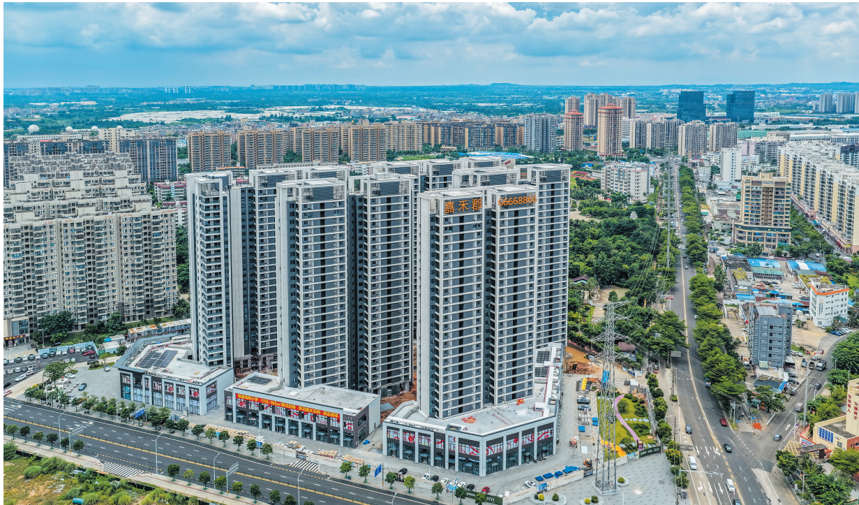
海虹化纤片区城市更新项目一期(嘉禾郡)楼宇外立面崭新亮相，配建路网已经通车。 本报记者 康登淋 摄
