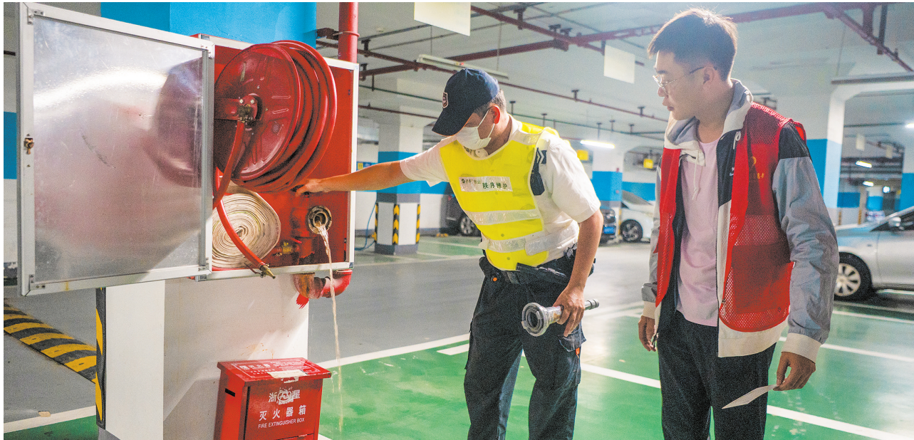
在海口保利中央海岸·熙园小区,物业安保人员和“双报到”党员在地下车库测试消防水管。 本报记者 石中华 摄
