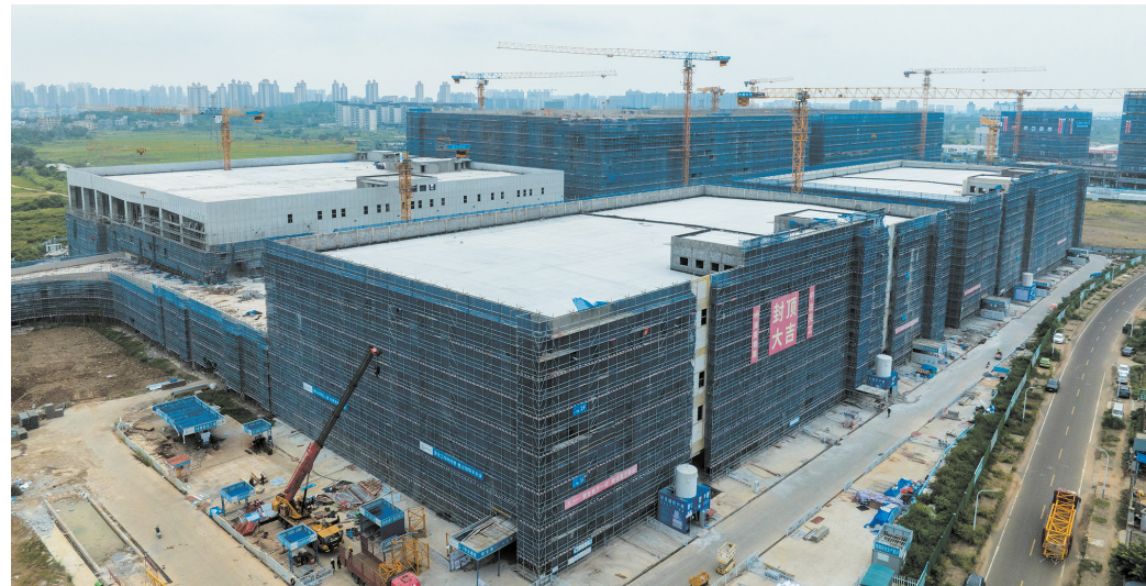
9月11日,美安生态科技新城新海陆岛物流园起步区项目正在加紧施工。 本报记者 石中华 摄
