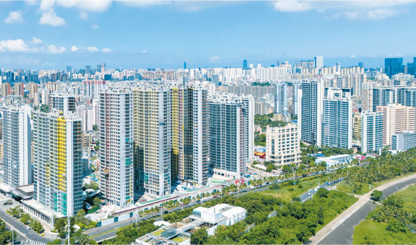
博雅片区(二期)项目总规模达到105.95亩,目前项目17栋高楼已全部封顶露出“真容”,施工人员正在进行外立面施工,并同步开展室内装饰装修和机电安装。
