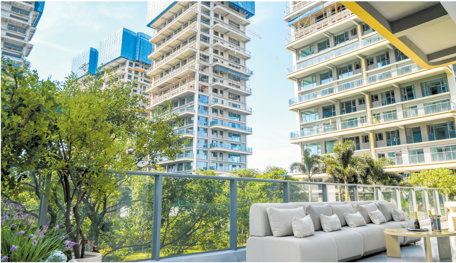
多栋住宅楼正有序推进建设。
