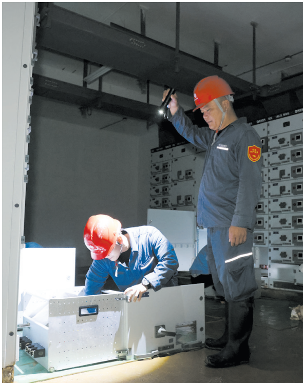
6月26日,海口供电局工作人员在五指山市开展抢修复电工作。通讯员 何达旺 摄
