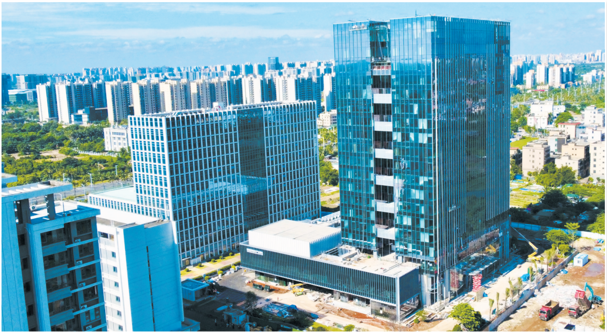
俯瞰正在冲刺完工的海南咨询设计产业基地项目。
