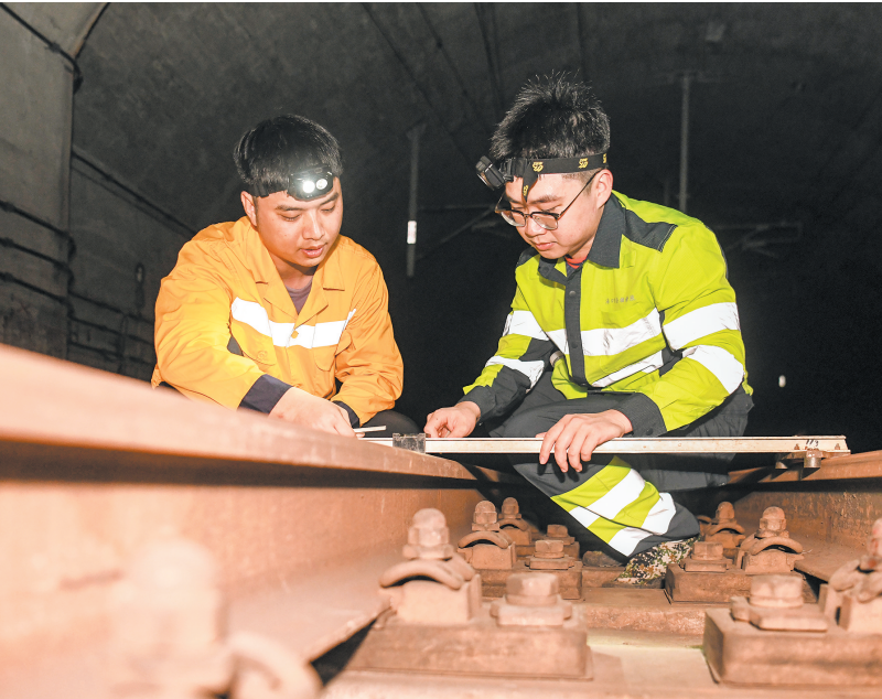
10月6日凌晨,海口东综合维修工区副工长王世江(左)正在进行道岔巡检作业。 本报记者 苏弼坤 摄
