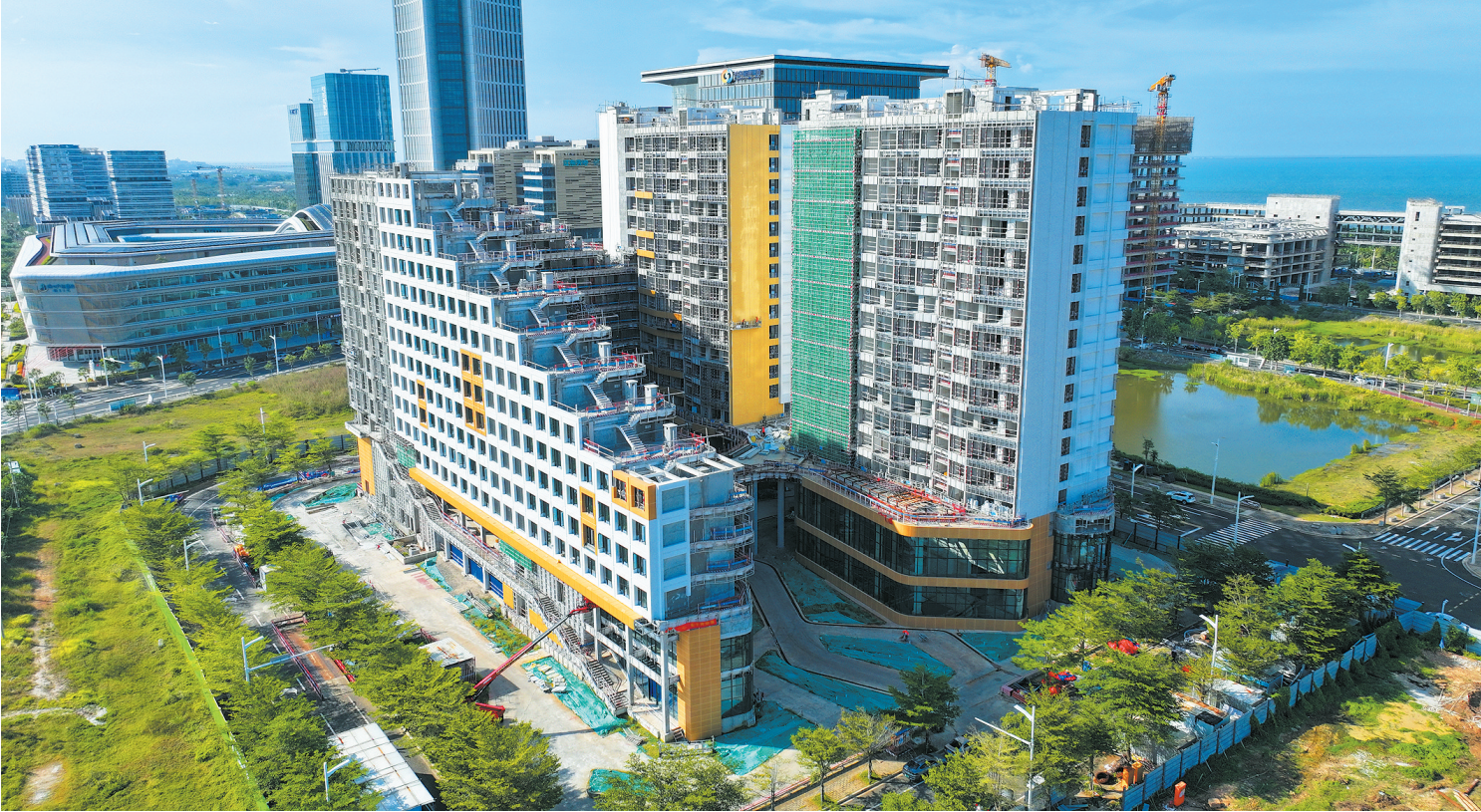
江东智慧国际公寓A区项目已全面进入装饰装修阶段。
