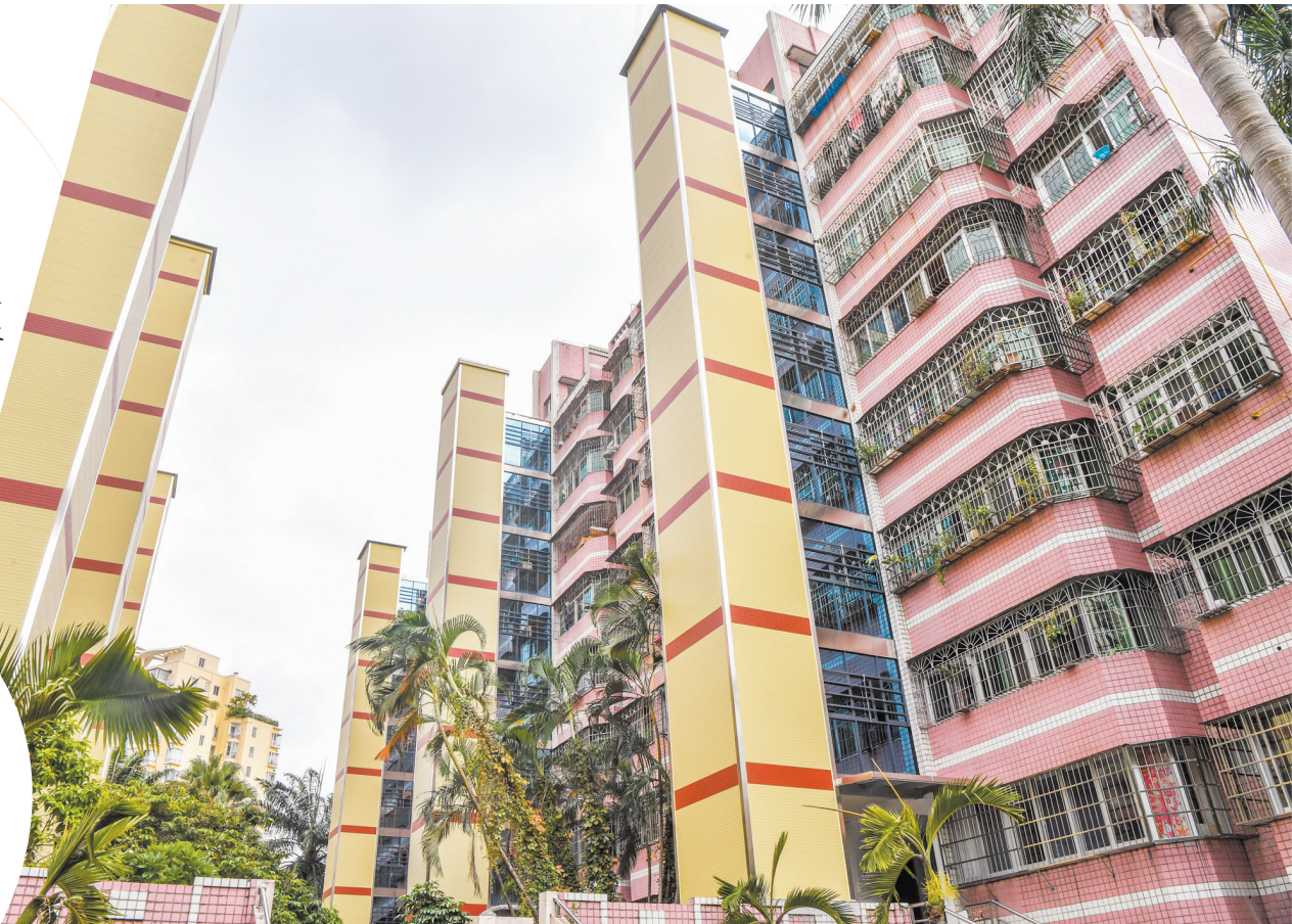
位于海德路的现代花园一期，一部部新加装的电梯矗立在外立面，成了小区一道亮丽风景。
