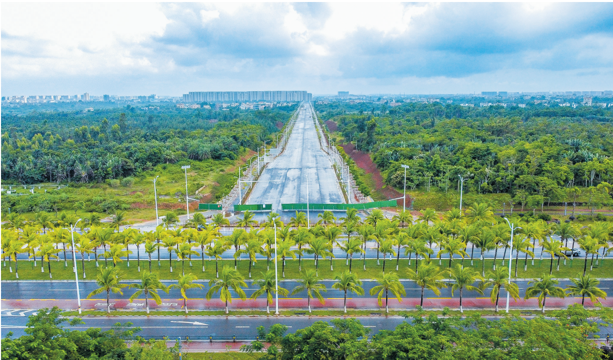
10月9日,俯瞰海口桂秀路(白驹大道至规划海涛大道段)项目施工现场。目前,该项目总体形象进度已超八成,正全力冲刺后续收尾工作,力争早日竣工通车。
