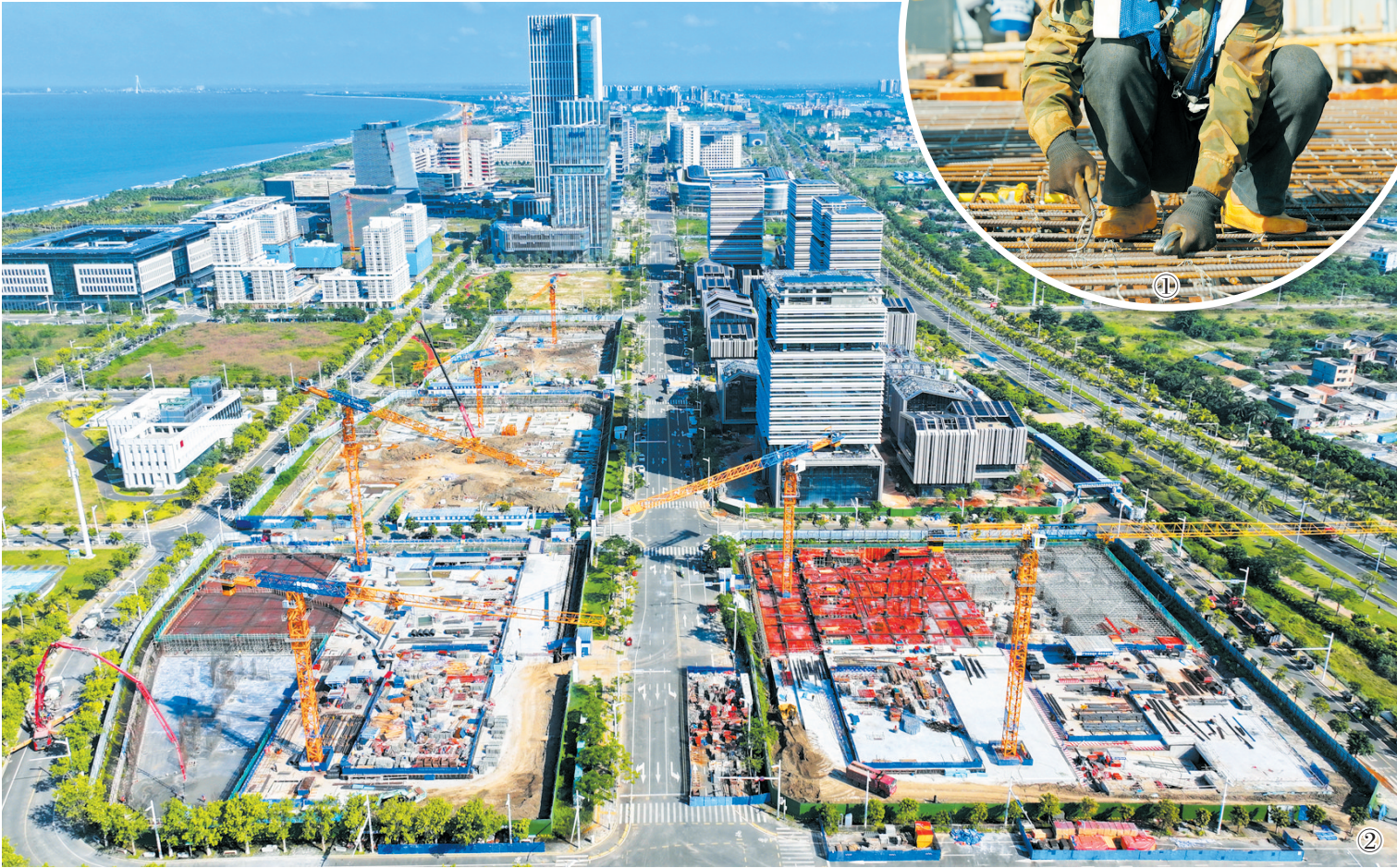
①10月13日,在项目施工现场,工人正有序开展工作。
